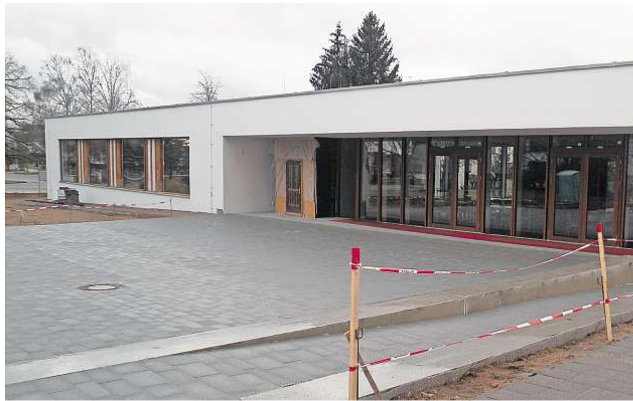
Der Zweckbau des neuen Pfarr- und Jugendheimes wird am 10. März durch Bischof Rudolf eingeweiht. FOTO: SCHIESSL
