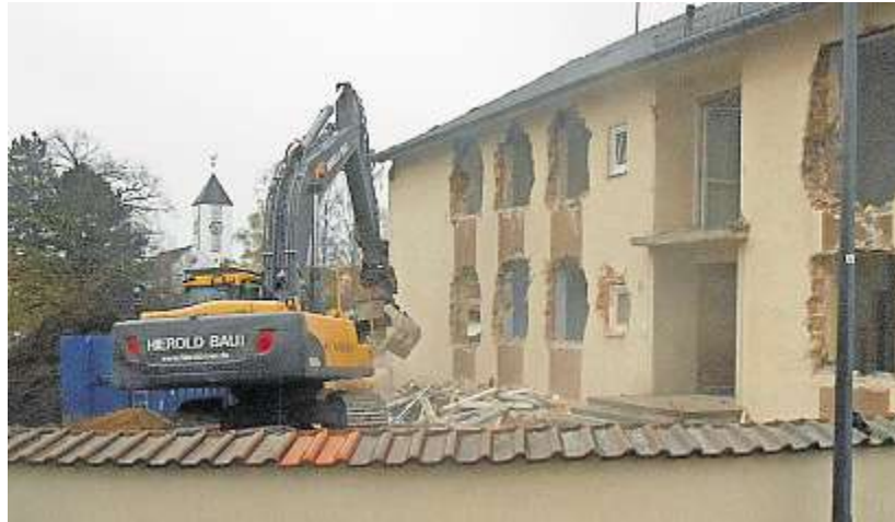
Im November war mit dem Abriss des alten Pfarrhofs begonnen worden, der dem neuen Pfarrheim Platz machte.
