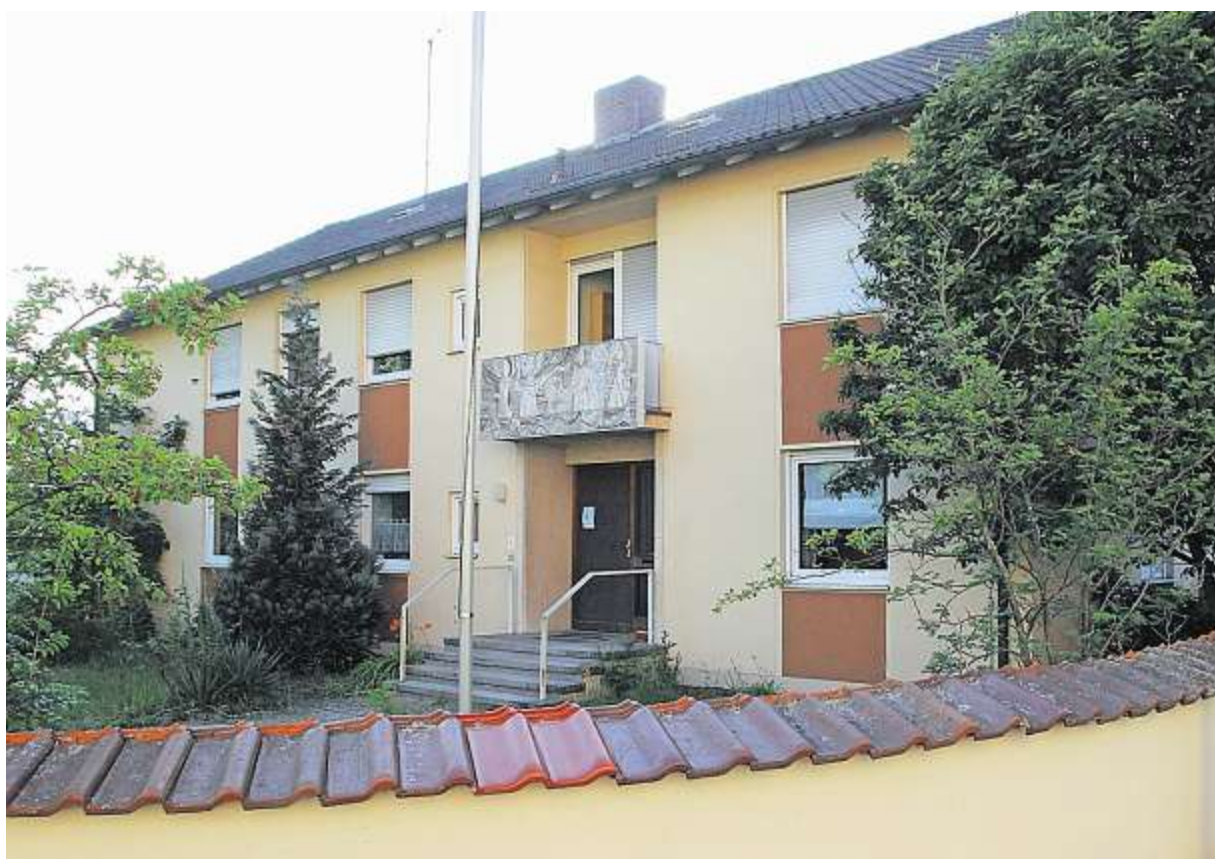
Der alte Pfarrheimbau soll noch in diesem Jahr abgerissen werden.
