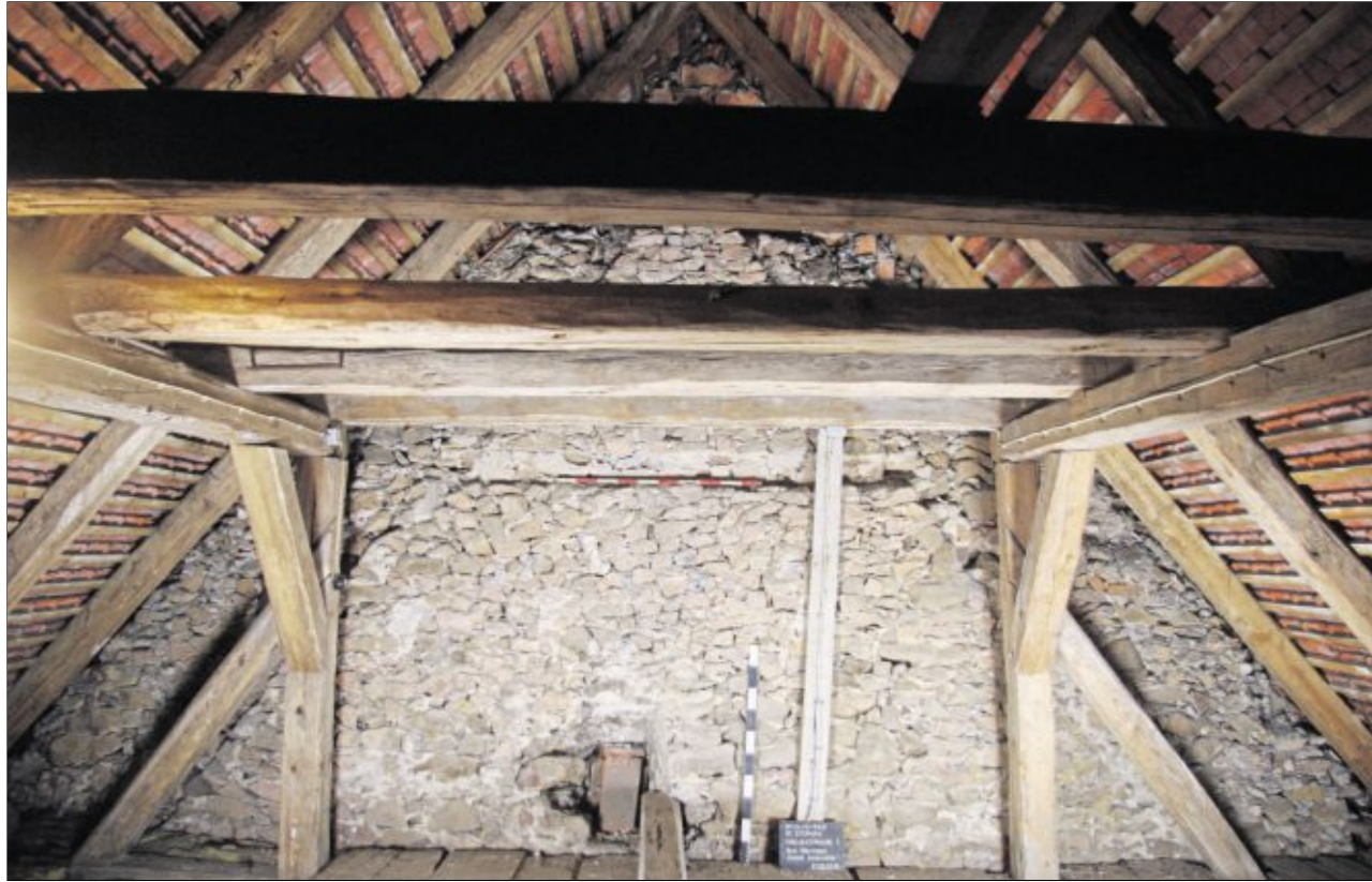
Der innen unverputzte Westgiebel lässt noch heute erkennen, dass er in späteren Jahren aufgemauert wurde.
